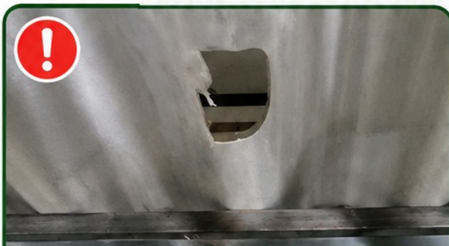
DETERIORO Y ROTURA DE TEJAS EN PRIMEROS PISOS
