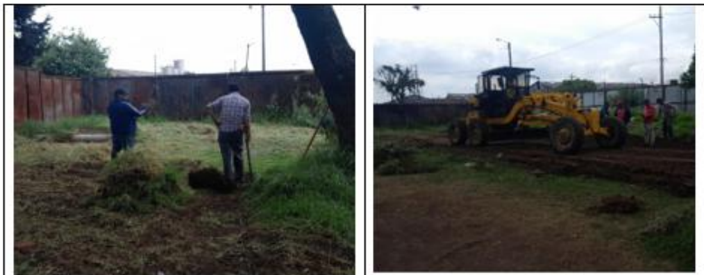
Movimiento de tierra y aplanamiento COSTO $2.200.000
