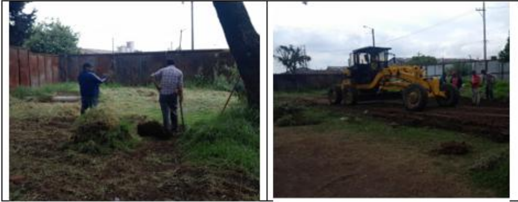
Movimiento de tierra y aplanamiento COSTO $2.200.000
