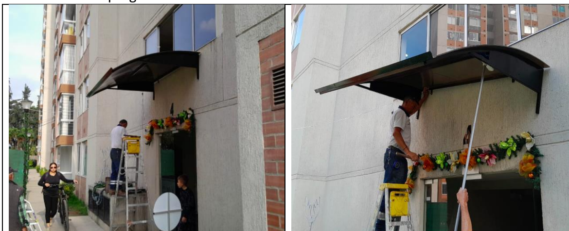
Instalación de la pergola en la Torre 4
